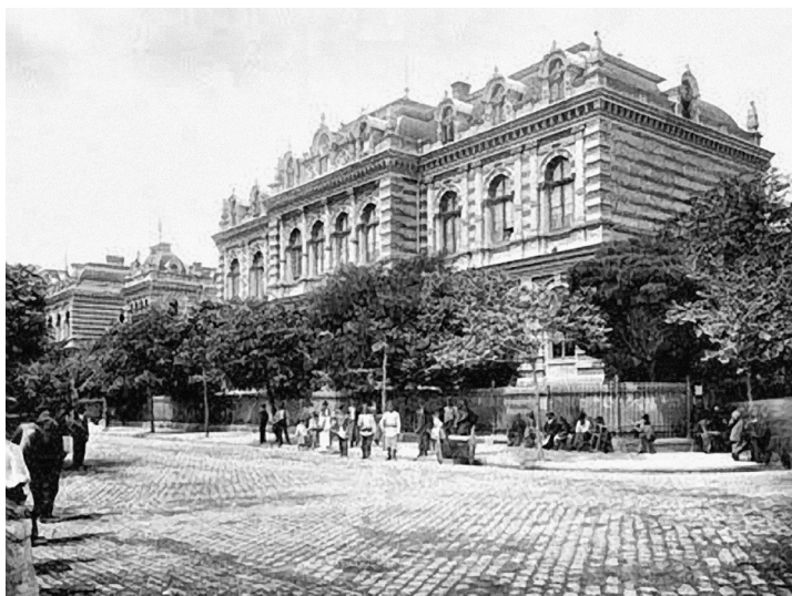
Fig. nr. 3. Vederea Clinicii de Balneologie a Spitalului Clinic Brâncovenesc, înainte de demolare
